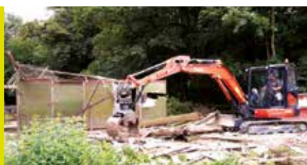
Auf dem Gelände von Haus Nazareth Leverkusen wurde im August mit den Bauarbeiten für das neue Wirtschaftsgebäude ...
